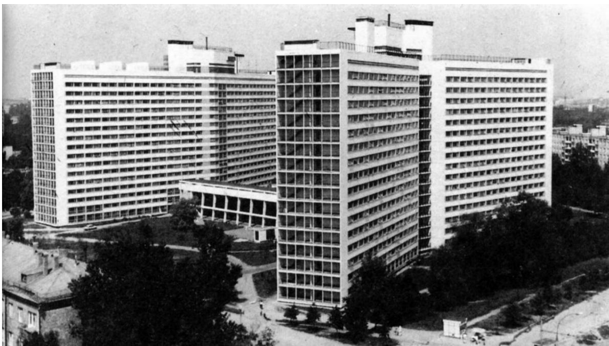
Ил. 1. Дом нового быта. Москва, 1965–1971. Архитекторы: Н. Остерман, А. Петрушкова, И. Канаева, Г. Константиновский, Г. Карлсен. Фото: Д. Есаков, 2015.
