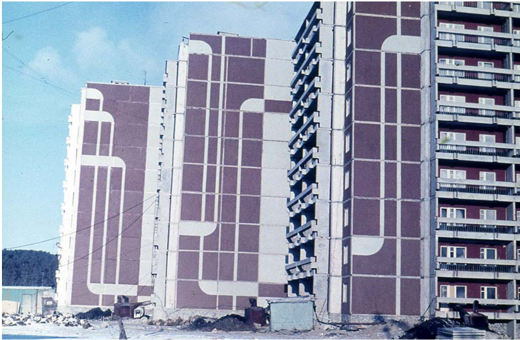
Ил. 9. Суперграфика, объединяющая в единую композицию фасады трёх жилых домов, 1980-е. Фото: А. Барабанов. Архив А. Барабанова и Е. Бухаровой.
